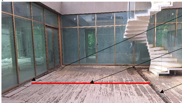
Canale di scolo laterale
